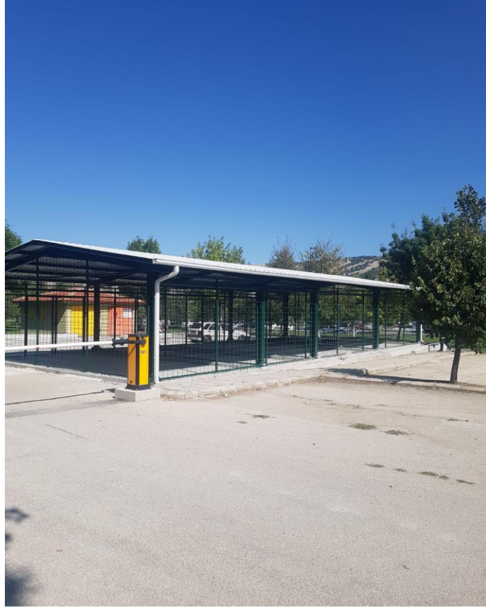
Şekil 3.3. Tamamlanmak üzere olan geçici depolanma alanları
