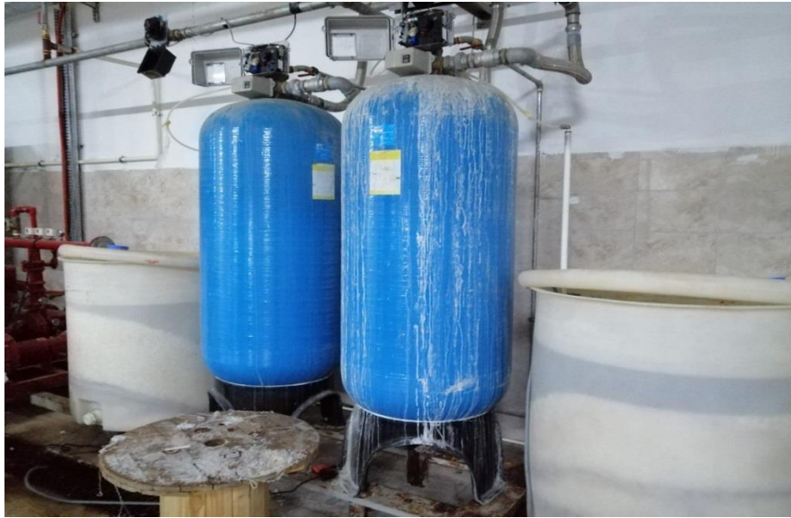
Şekil 11. Su yumuşatma cihazı (iyon değıştirici)
