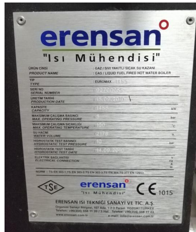
Şekil 7. Gaz yakıtlı sıcak su kazanı etiket değerleri
